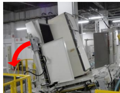
新ライン：冷蔵庫転倒装置
