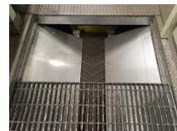
グレーチング床(ねじ回収コンベア)
