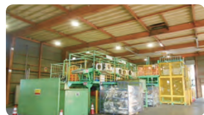
洗濯機解体ライン
