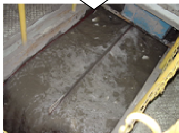
湿式選別機内の二次選別機
