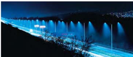
ブルガリアの幹線道路に設置されたLED 道路灯
