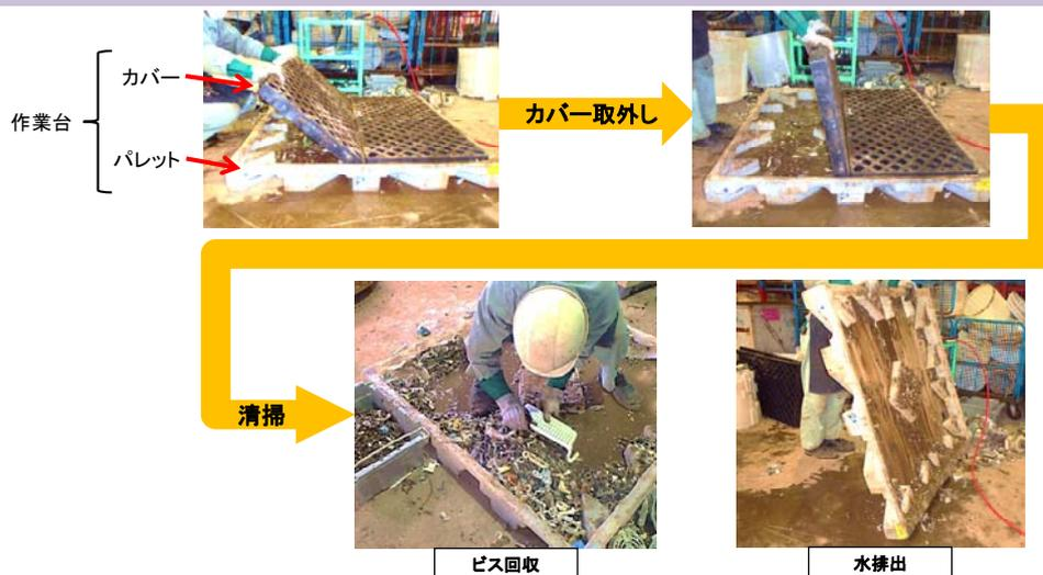
水、ビス等を床に飛散させることなくパレット内に回収できる。パレットはカバーの取外しが容易な為、パレット内に溜まった水、ビス回収時はカバーを取り外し、ビスを手作業で取り除き、水はパレットを傾け排水溝に流す。
