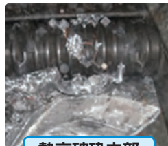
熱交破碎内部
