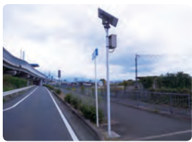
ソーラー式監視カメラの設置
