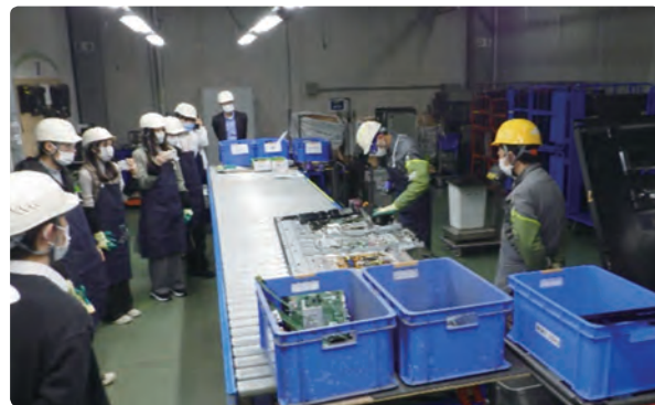
解体デモ風景
