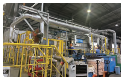
冷蔵庫解体ライン
