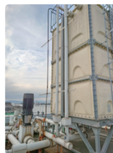
＜散水タンクを屋上に設置＞
