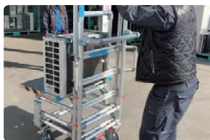
・エアコン室外機の運搬
