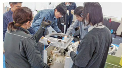
解体実習の様子②
